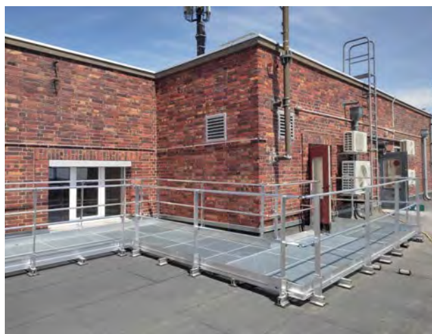
Durchdringungsfreie selbsttragende Konstruktion
